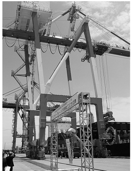
「ガントリークレーン2号機」が供用開始
