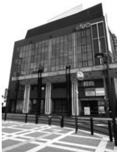
デュオビル解体(昭和40年建設)
