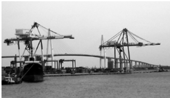
ガントリークレーンが2基体制となった 富山新港多目的国際ターミナル
